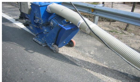
LIMPIEZA Y PREPARACIÓN DE PLATABANDA EN HOMIGON EN VIADUCTOS Y GALERIAS
