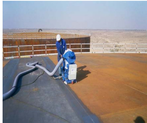
Granallado de superficie metálica exterior de tanque en refinería.
