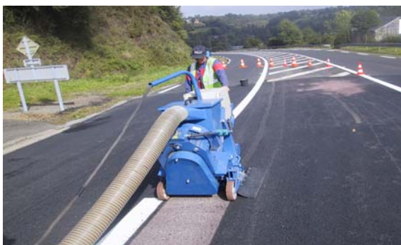
LIMPIEZA Y PREPARACIÓN DE PLATABANDA EN HOMIGON EN VIADUCTOS Y GALERIAS
